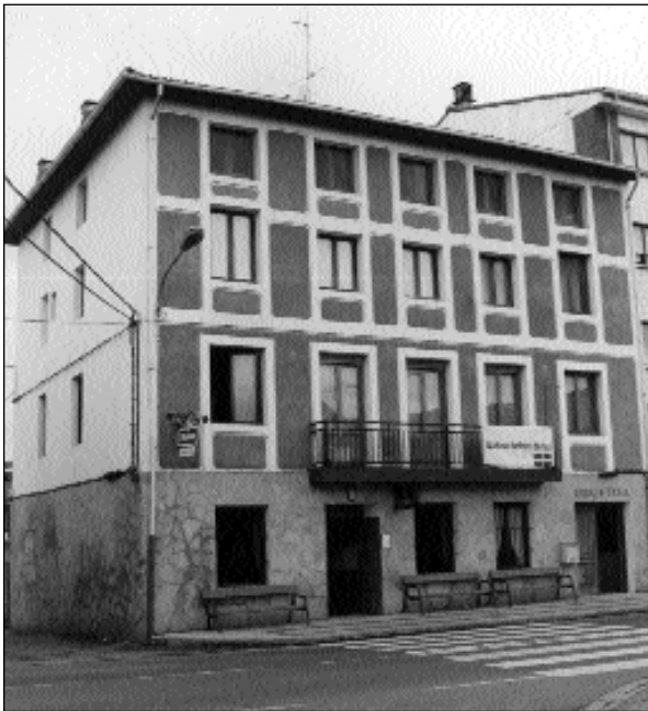
Abeneruak eta Udal-batzak batera egin eben Udaletxea eta barrenean erriko taberna.
